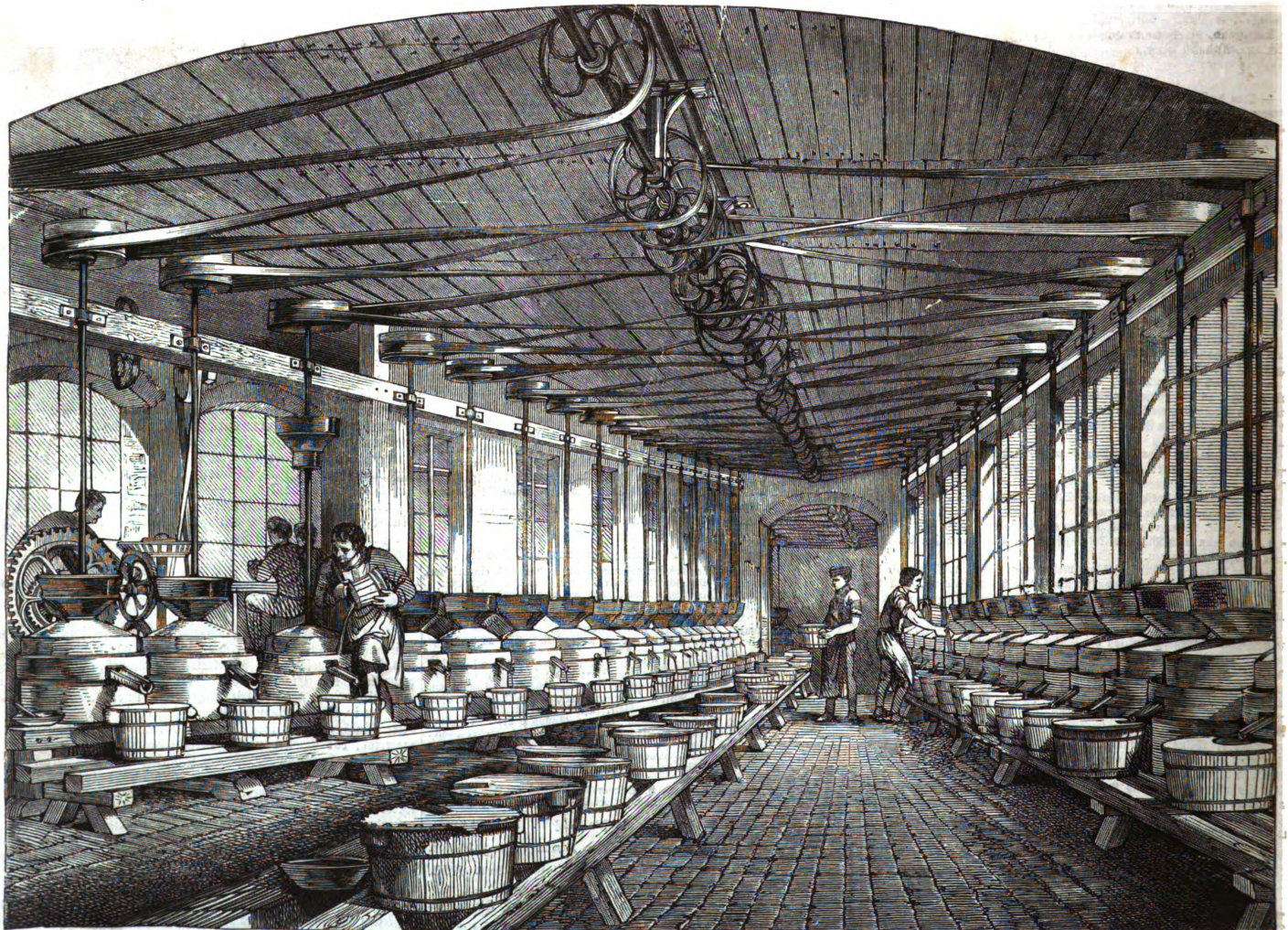
Wälsenraum in der Bleichfabrik von Großberger u. Ranz in Nürnberg.
